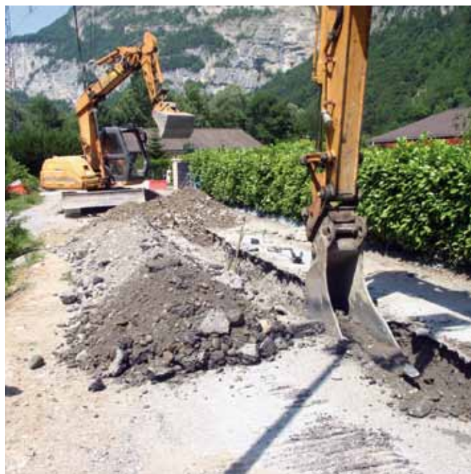
Remplacement conduite d'eau rue des Coudrays
