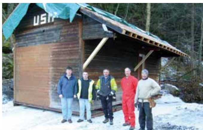
La cabane de la chasse avant travaux
