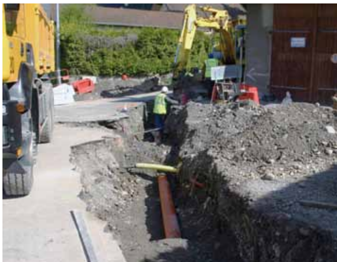
Rond-point RD 1 205 et route du Crêtet
