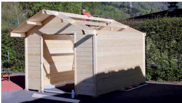
Pose d'un chalet en bois (entrepôt matériel scolaire)
