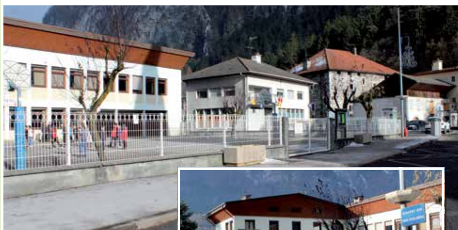
Réfection de la clôture et du portail
