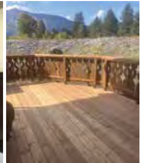
Terrasse en pin autoclave
