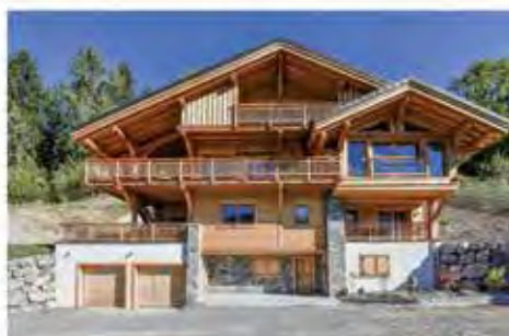
Construction de chalet
