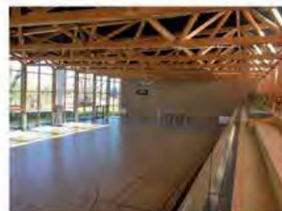
Ossature et Charpente bois
