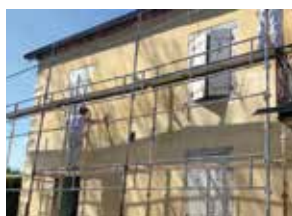
Rénovation de bâtiments existants (ravalement de façade, peintures, bardage...)
