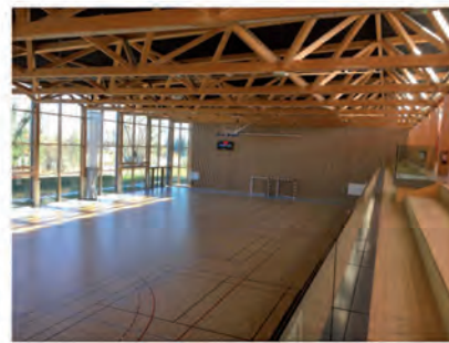
Ossature et Charpente bois
