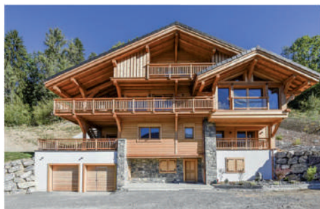
Construction de chalet
