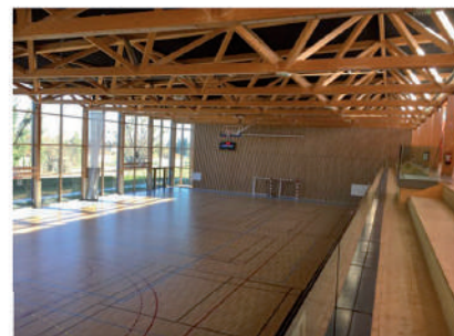
Ossature et Charpente bois
